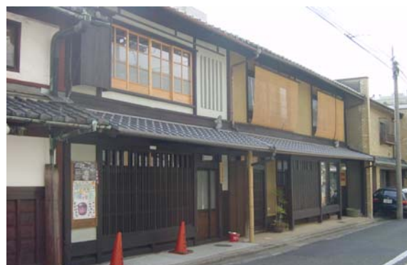
耐震補強された大正時代の京町屋（右側）
